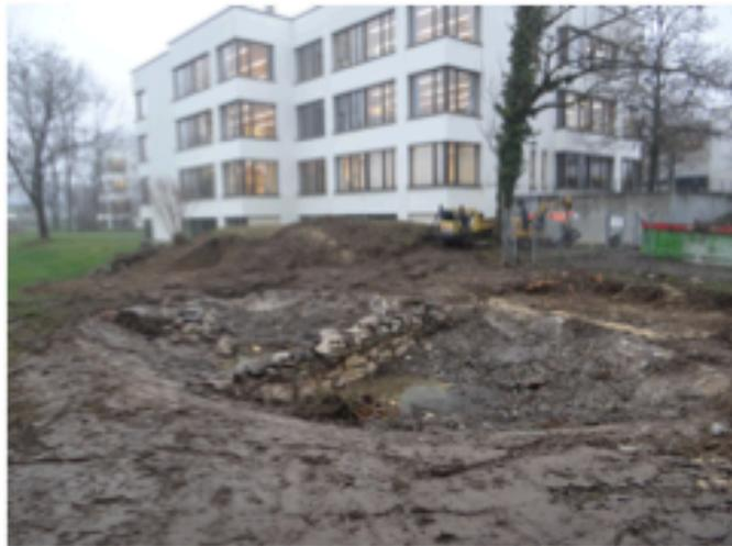
Die 1981 mit armiertem Beton gebaute Teichwanne ist intakt und hat nur wenige Schäden.
